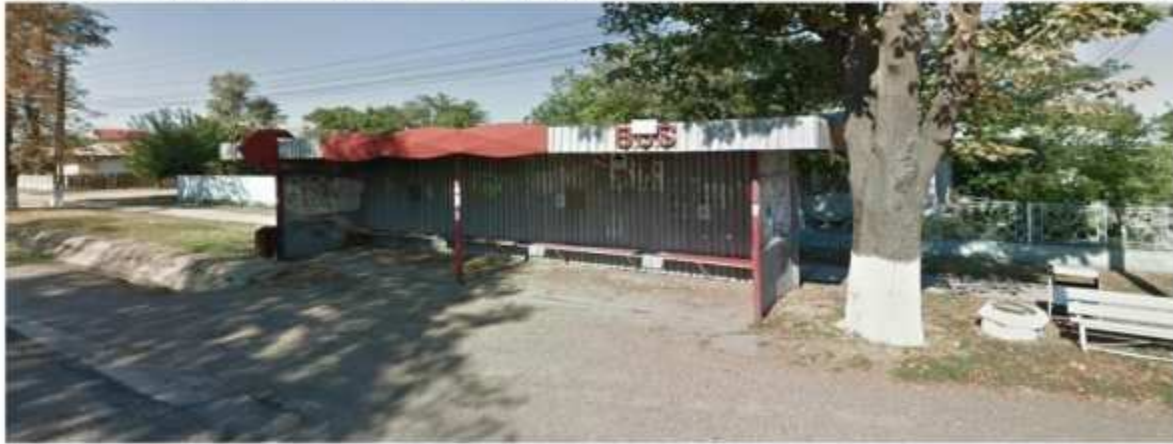
Figura nr. 21. Stațiile de îmbarcare/coborâre a călătorilor de la nivelul comunei
